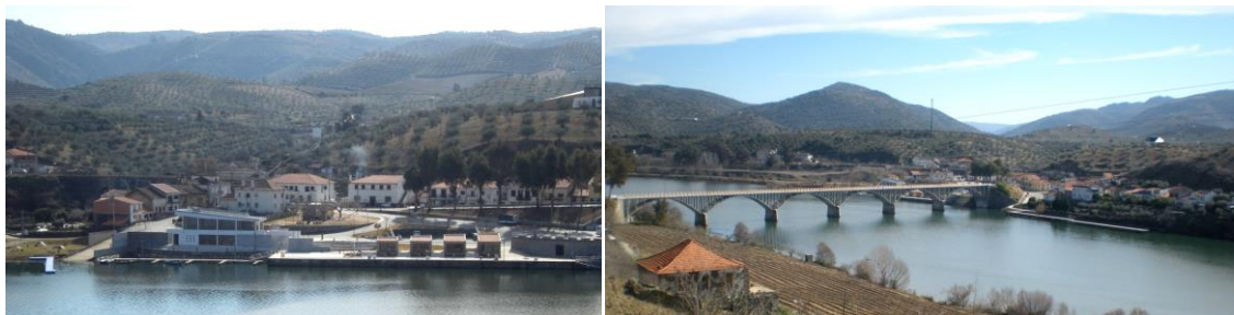
Figura 23 – Vistas gerais do Cais de Barca de Alva (em baixo: à esquerda, cais a montante da ponte; à direita, cais a jusante da ponte)
