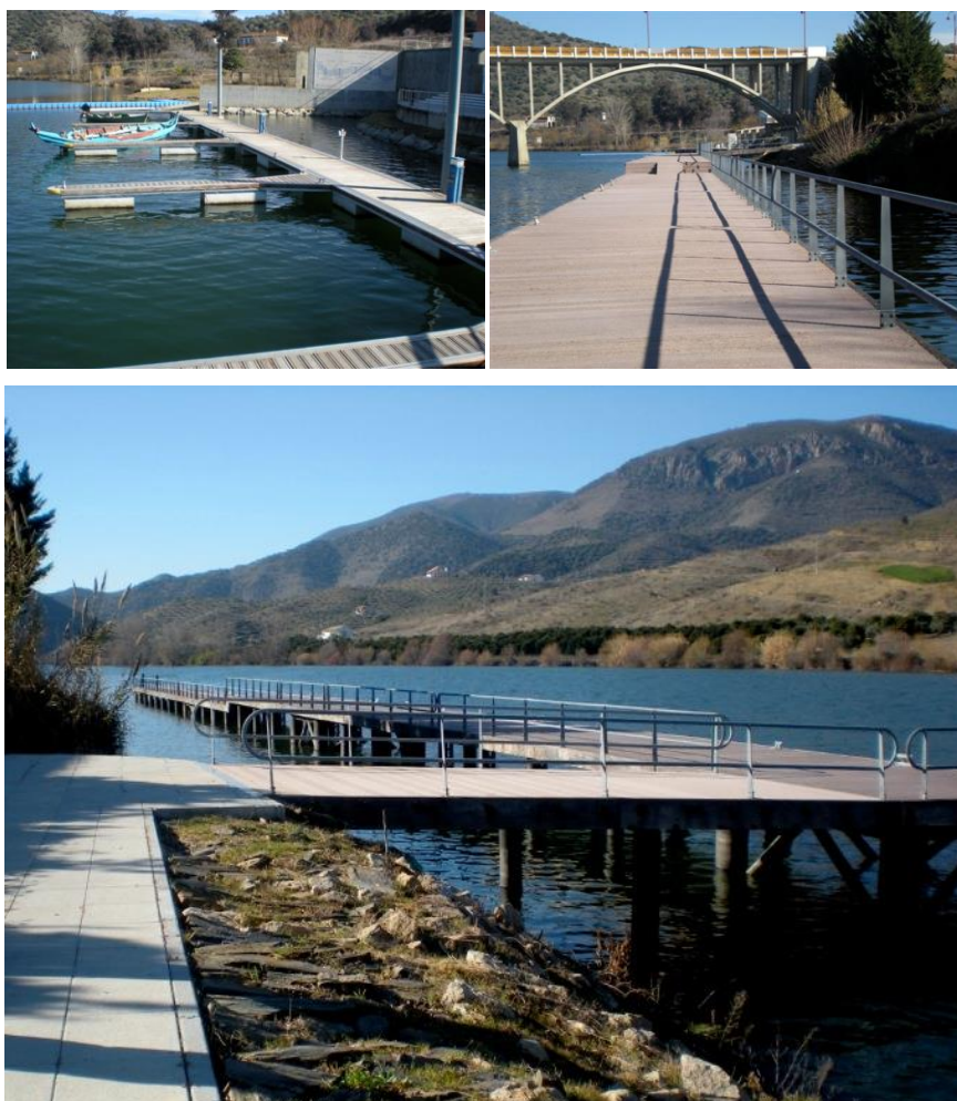
Figura 24 – Vistas das instalações portuárias em Barca de Alva
