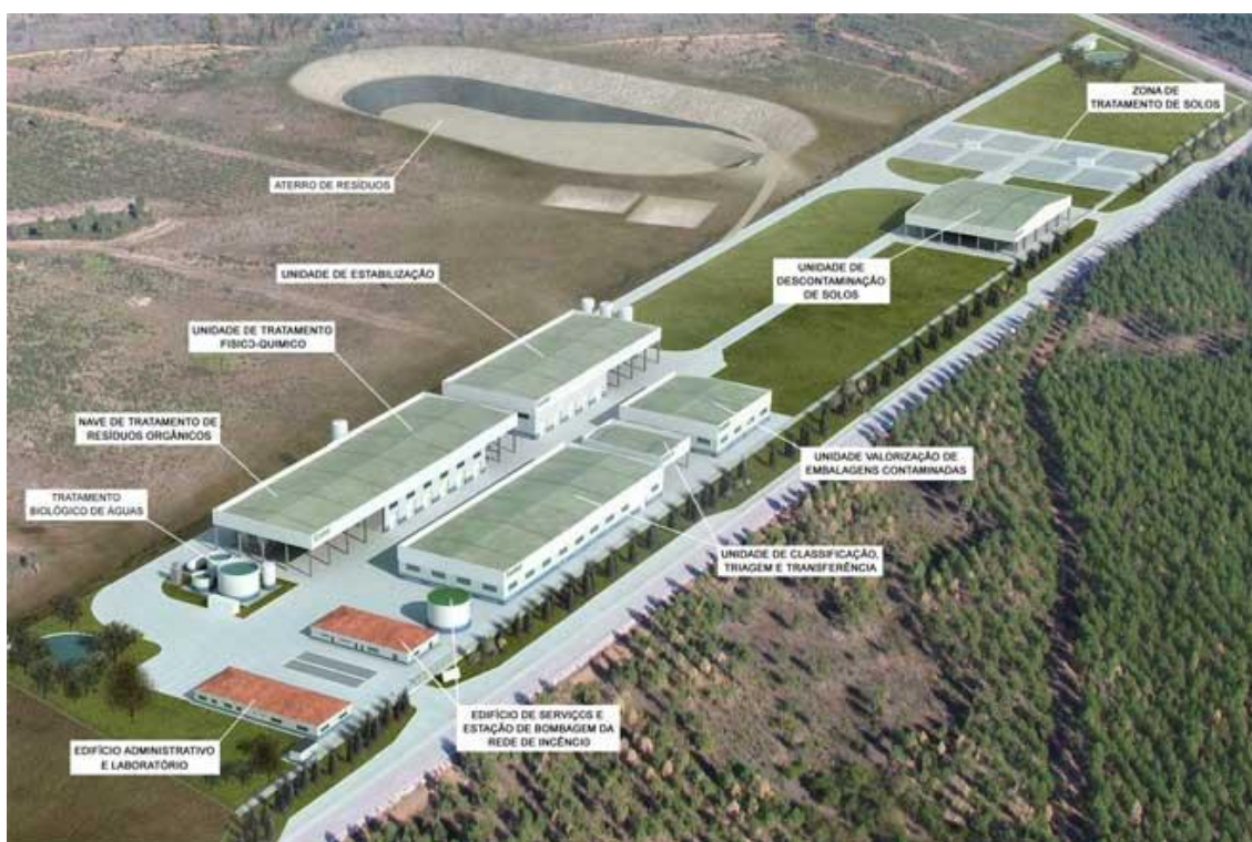
Figura 31 – Representação esquemática de um CIRVER
