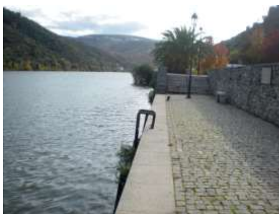
Figuras 17 – Vista do Cais de Sabrosa
