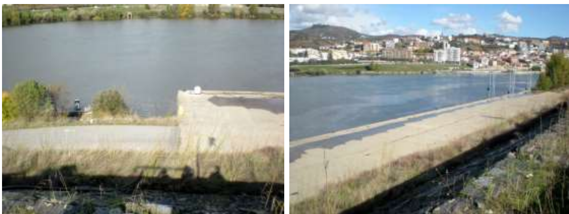
Figuras 13 – Vistas do Porto comercial de Régua-Lamego, ao nível do cais
